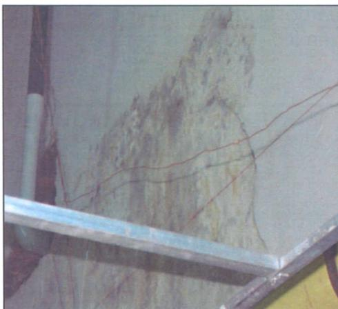
Fotografía 8. Manchas de humedad y hongos en la superficie de los muros
