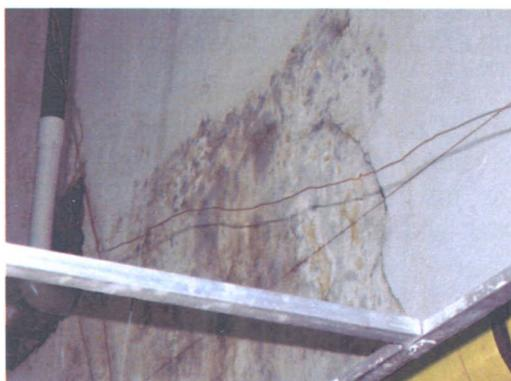
**Foto No. 5.** Mancha de humedad en el espacio anexo al laboratorio de física
