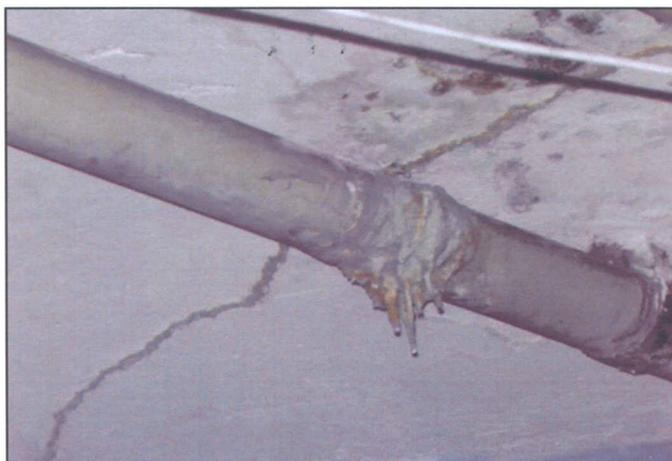
**Fotografía 5. Concreciones formadas en la tubería**
